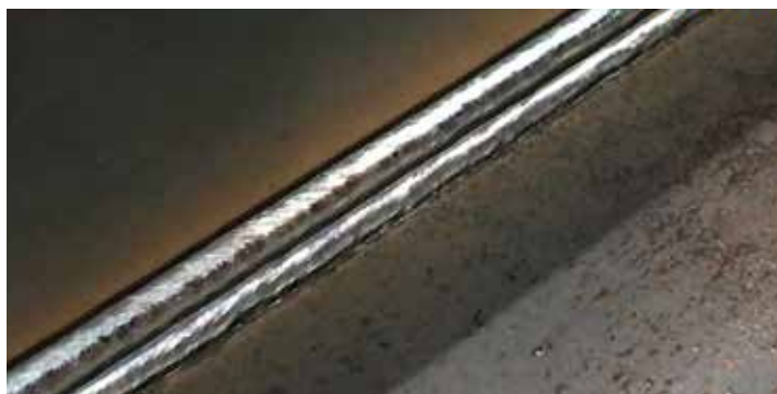
図8 柱大組立溶接ロボットシステムによる梁溶接のビード外観
