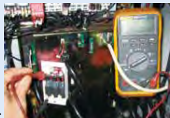
バッテリー電圧測定状況→
