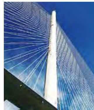
写真2-2 香港ストーンカッターズ橋（主塔の海拔175m以上部分）
