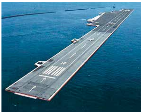
図4 長さ1000mのメガフロート実証実験モデル(国土交通省)
