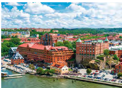
Gothenburg市内中心部
