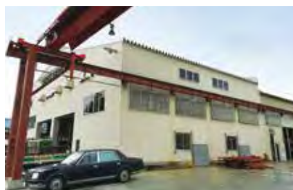
増築工場外観（梁加工場）
