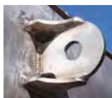
立向上進溶接
