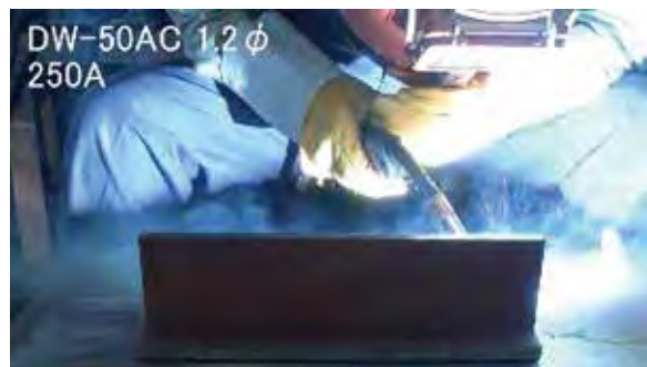
F 1 DW-50ACの溶接
