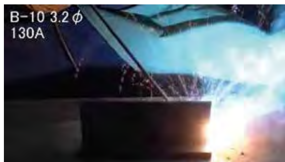
F 1 B-10の溶接
