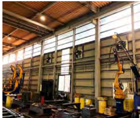
REGARC™ 搭載鉄骨柱大組立2アーク溶接ロボットシステム
