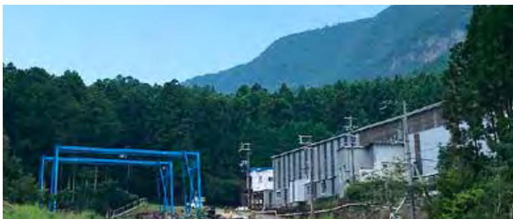
事務所・工場外観
