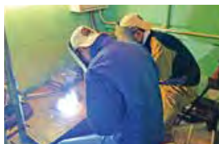
溶接サポーターの様子
