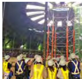
2014年 石狩LNG基地
