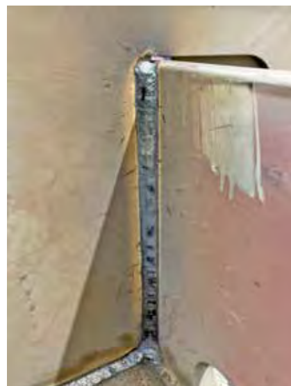
図10 溶接ビード（立向溶接部）
