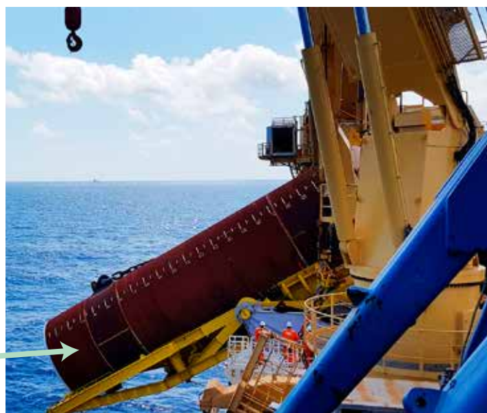
モノパイル敷設前の外観写真
