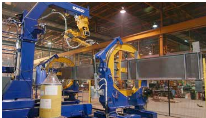
図7 天吊柱大組立溶接ロボットシステムによる梁溶接
