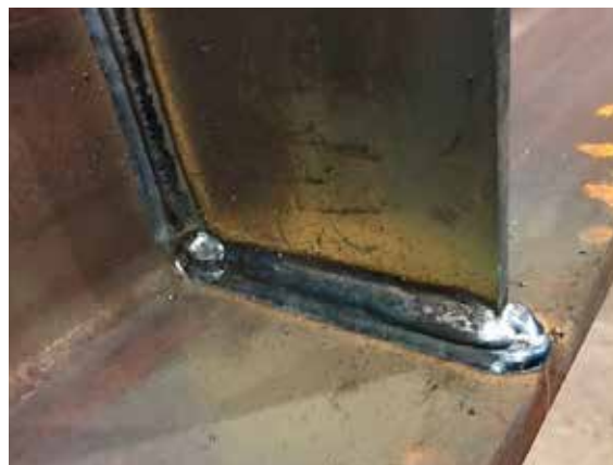
図5 天吊梁溶接ロボットシステムによるスチフナ×フランジ溶接
